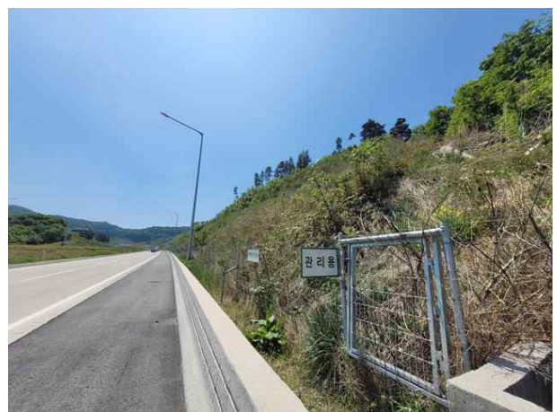
하단 야생동물유도울타리 전경
