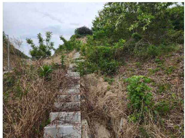
산마루측구, 점검계단 전경
