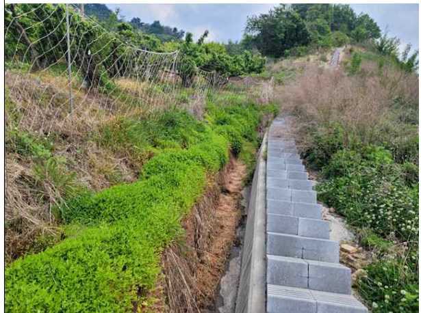
산마루측구, 점검계단 전경
