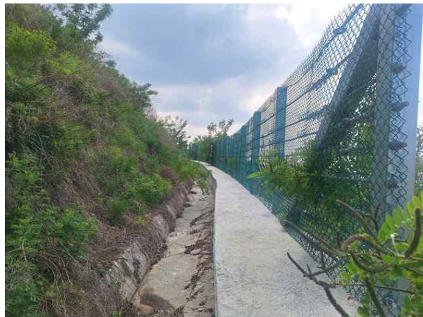
소단 배수로 전경
