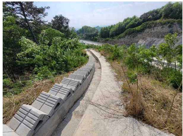
점검계단, 산마루측구 전경
