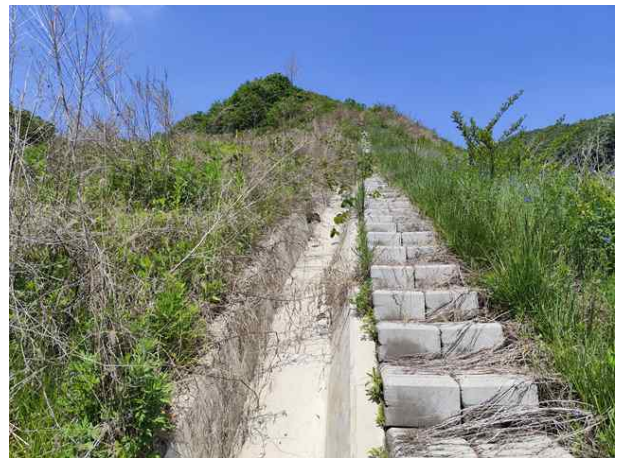
산마루측구, 점검계단 전경
