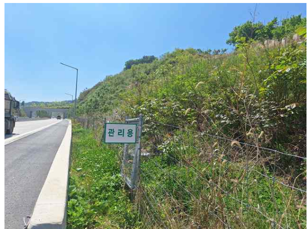
하단 야생동물유도울타리 전경
