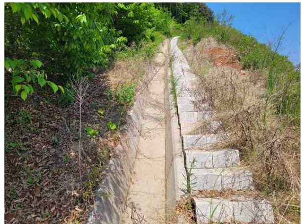
산마루측구, 점검계단 전경
