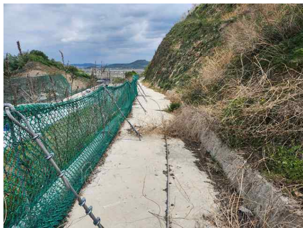
소단 배수로 전경
