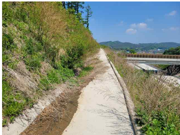
소단 배수로 전경
