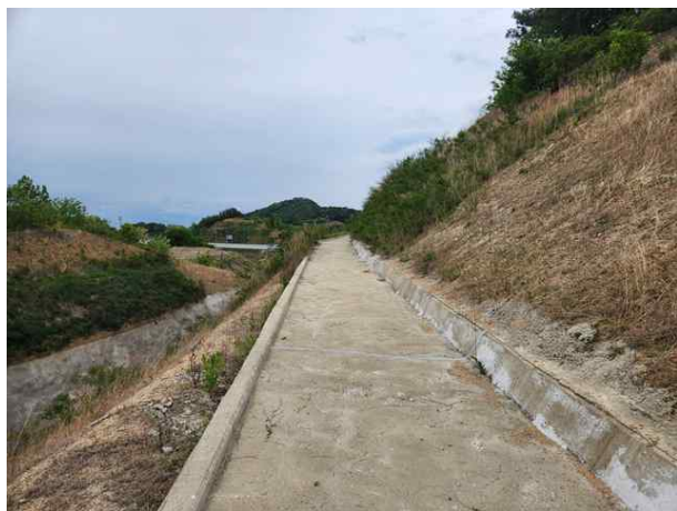
소단 배수로 전경
