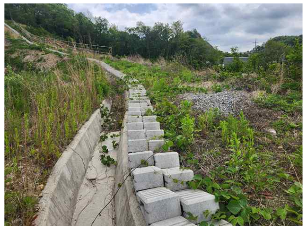
산마루측구, 점검계단 전경
