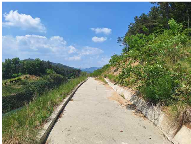
소단 배수로 전경
