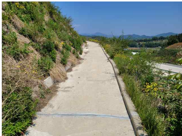
소단 배수로 전경
