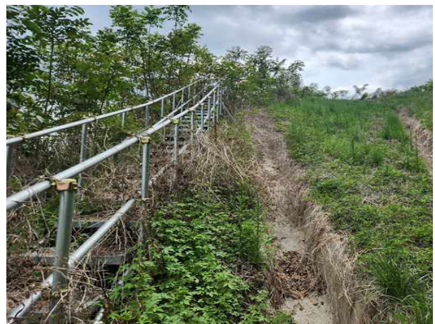
산마루측구, 점검계단 전경
