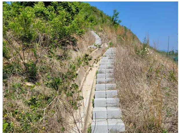
산마루측구, 점검계단 전경
