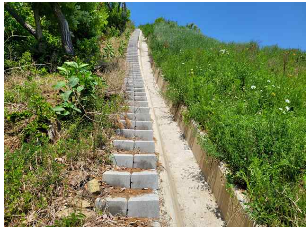
산마루측구, 점검계단 전경
