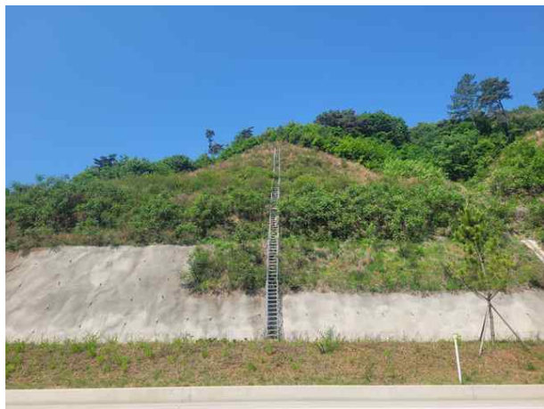
슛크리트, 계단식옹벽 전경
