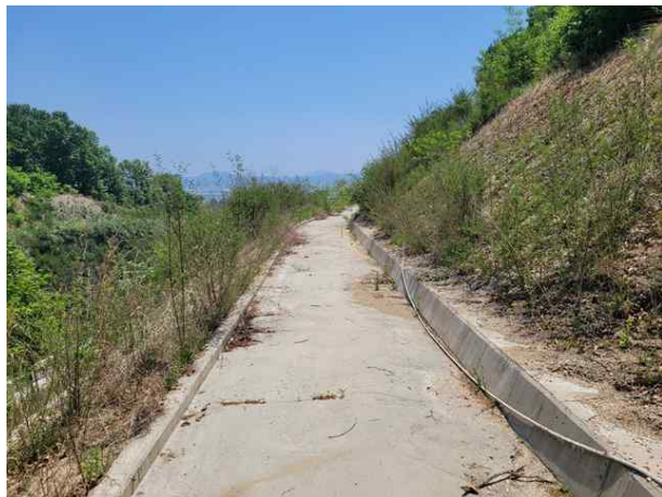
소단 배수로 전경
