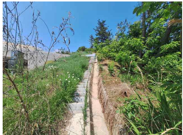
산마루측구, 점검계단 전경
