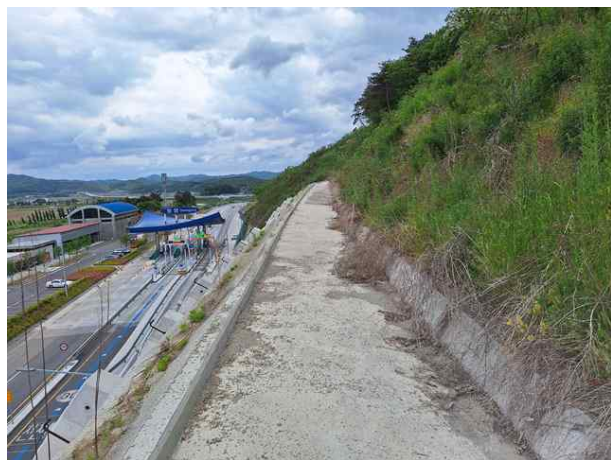
소단 배수로 전경
