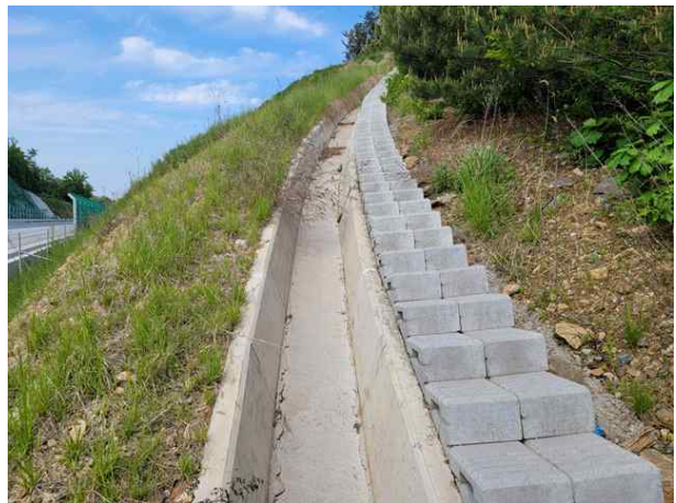
점검계단, 산마루측구 전경
