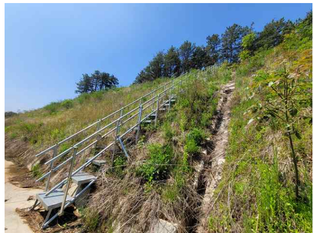
수직도수로, 점검계단 전경
