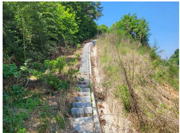
산마루측구, 점검계단 전경
