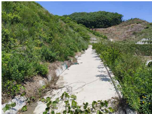
소단 배수로 전경
