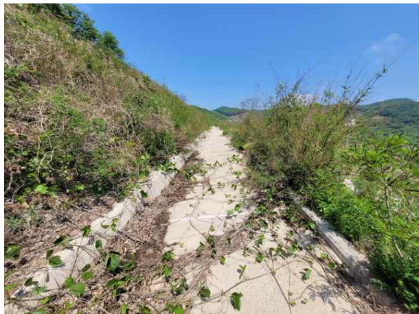
소단 배수로 전경
