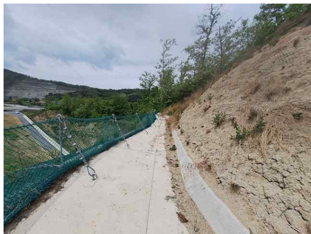
소단 배수로 전경
