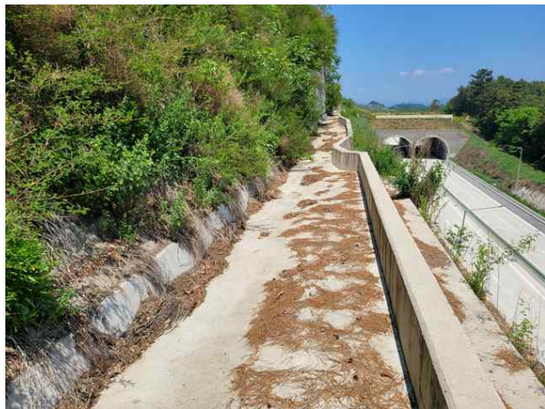
소단 배수로 전경
