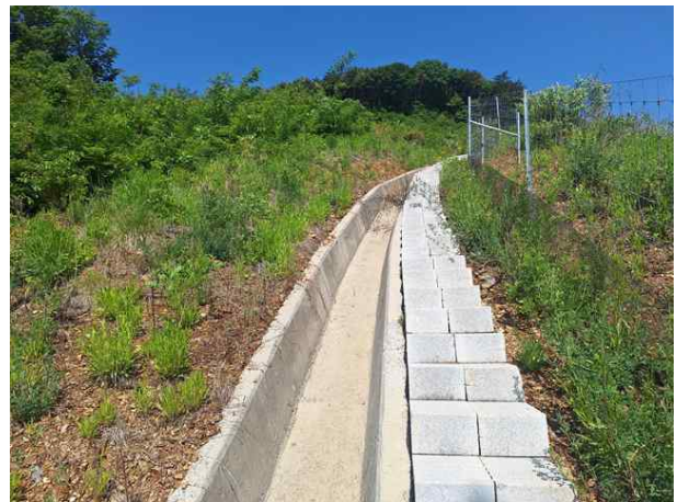
산마루측구, 점검계단 전경
