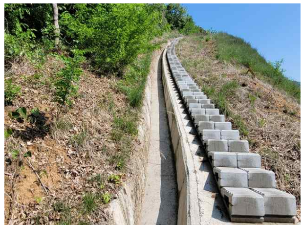
산마루측구, 점검계단 전경
