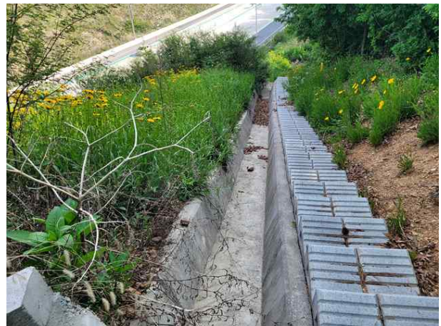
점검계단, 산마루측구 전경
