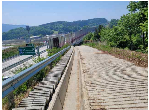
산마루측구, 점검계단 전경
