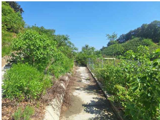
소단 배수로 전경
