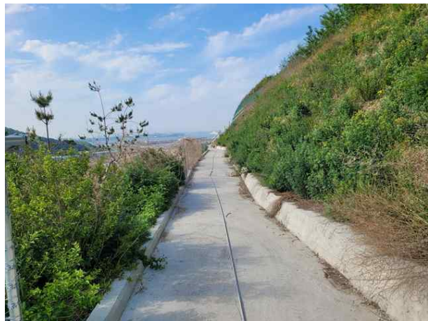
소단 배수로 전경
