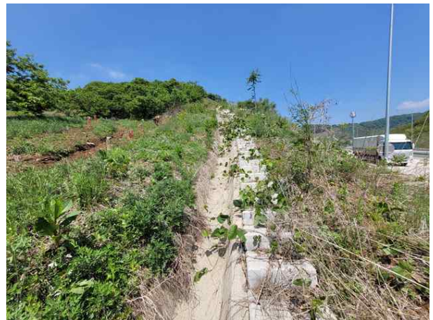
산마루측구, 점검계단 전경
