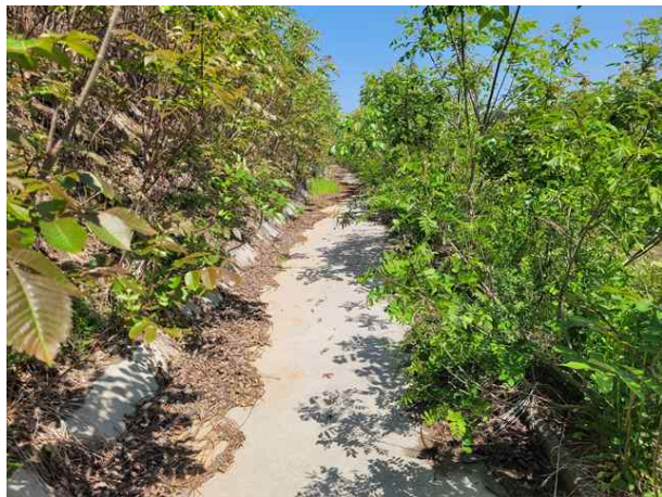
소단 배수로 전경
