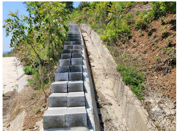
산마루측구, 점검계단 전경
