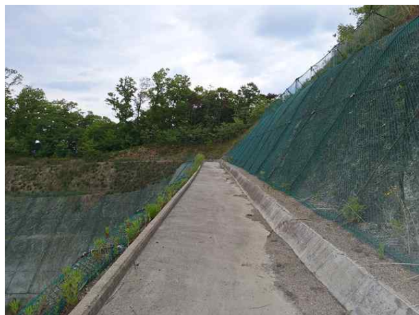
소단 배수로 전경
