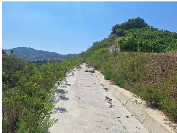
소단 배수로 전경
