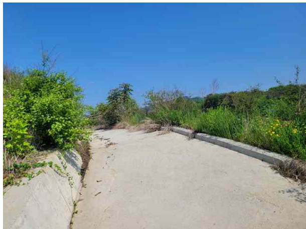
소단 배수로 전경
