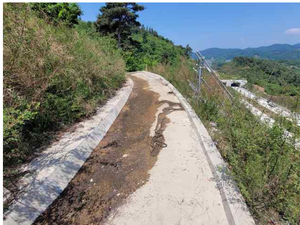
소단 배수로 전경
