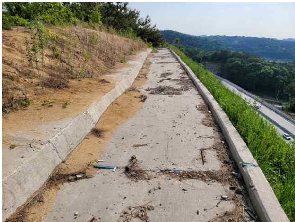
소단 배수로 전경
