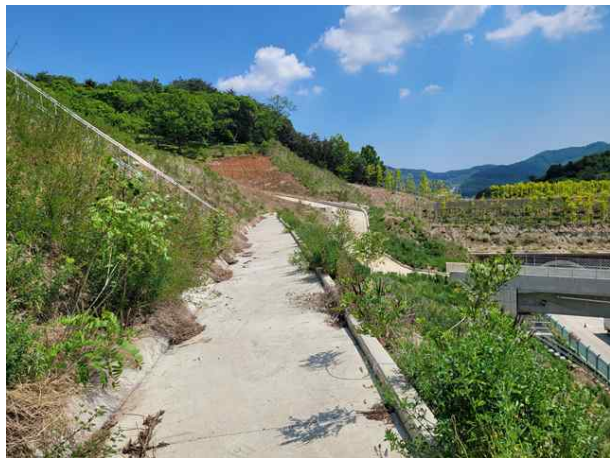
소단 배수로 전경
